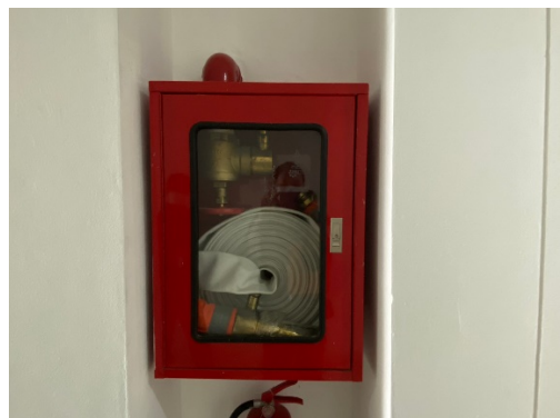
รูปที่ 44 ถังดับเพลิงและตู้เก็บสายฉีดน้ำดับเพลิง
